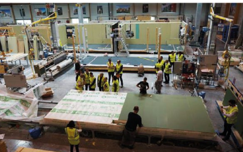
Montage du centre d'urgence, ©Aurore, 2016
