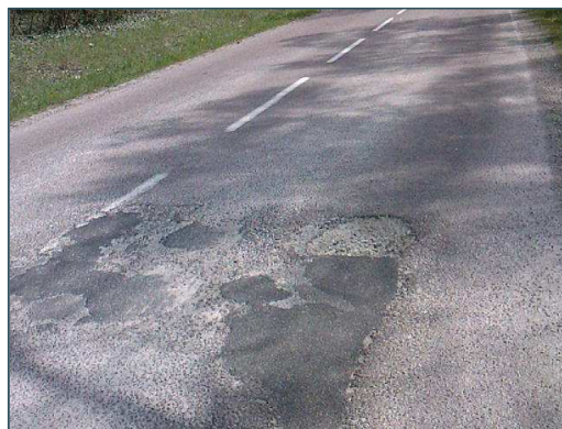
Nid de poule et réparations sur enrobé noir
