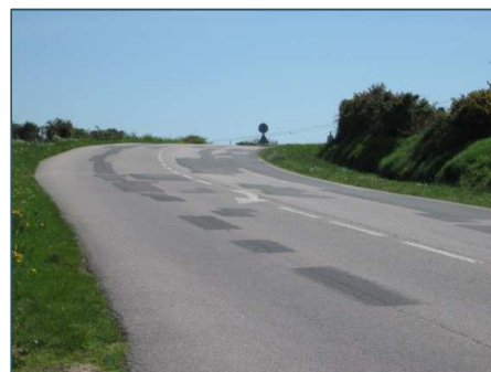
Réparations sur enrobé noir
