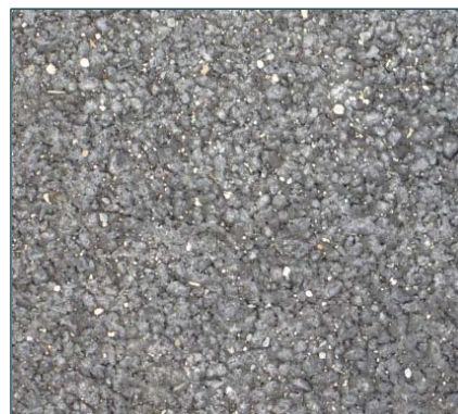
Aperçu détaillé d'enrobé noir
