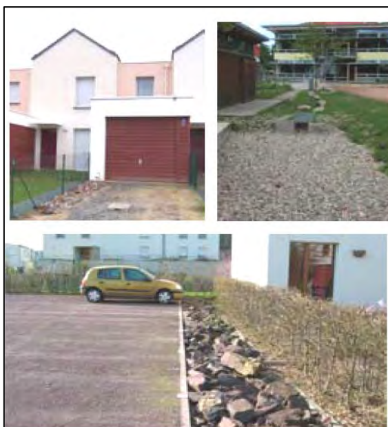
Tranchées drainantes récoltant les eaux de parking (Saint Jacques de la lande, 35)
