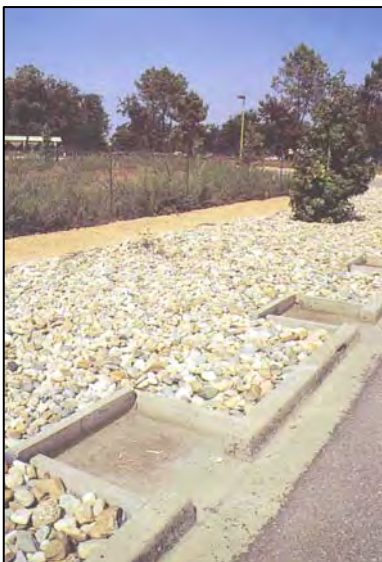
▶ Tranchées le long de la voirie
