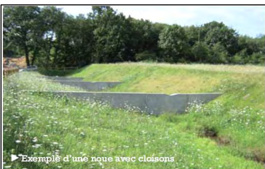
▶ Exemple d'une noue enherbée
