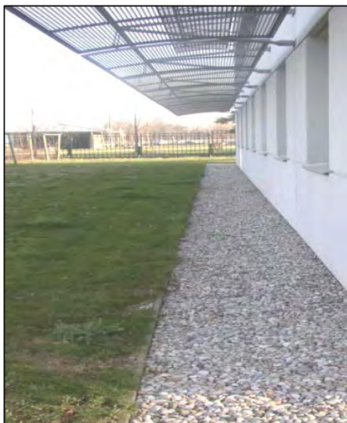
▶ Tranchées sous toit
