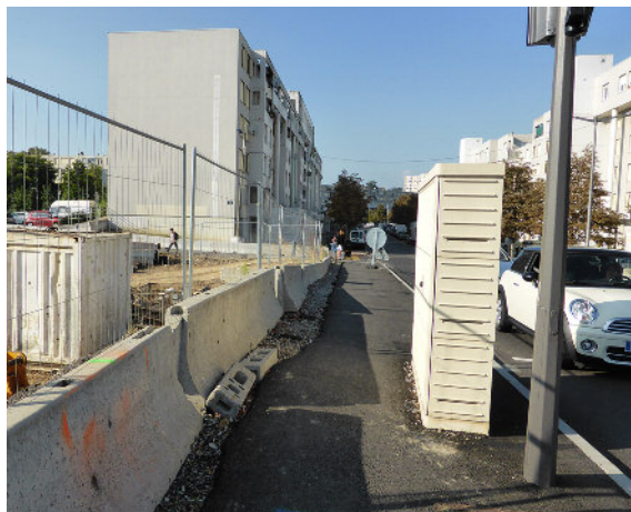
La clôture du chantier préserve un cheminement sans obstacle
