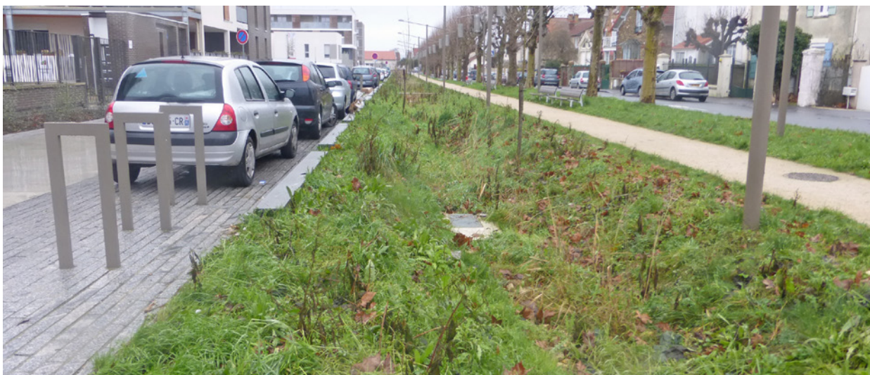
Noue au sein du quartier Clause Bois Badeau à Brétigny-sur-Orge
