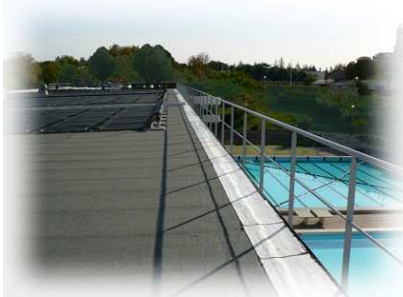
Photo 3 : Moquette solaire de la piscine de Villeurbanne
