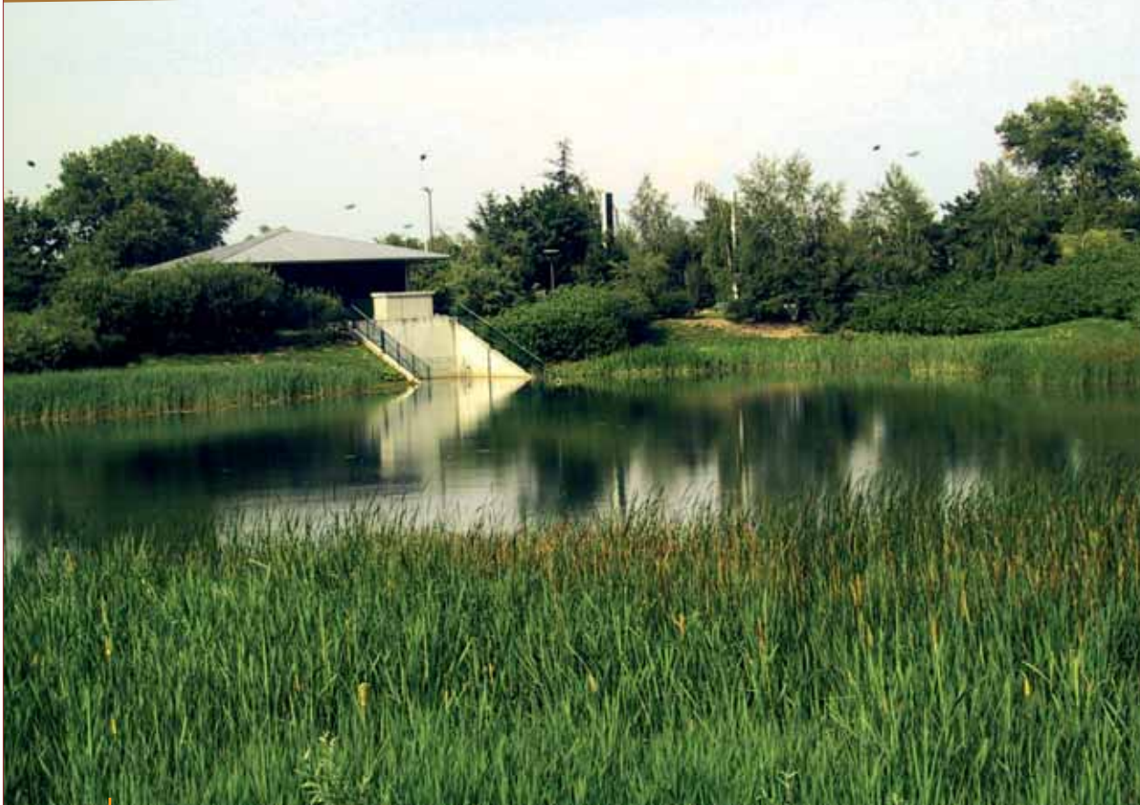
Aménagement paysagé d'un des deux bassins de rétention
