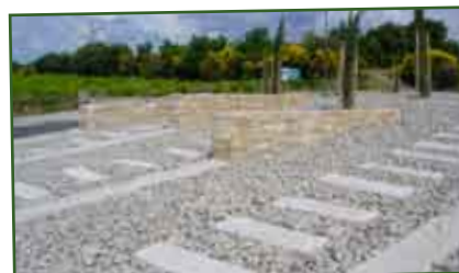
Aménagements minéraux sur des giratoires d'entrée de villes
