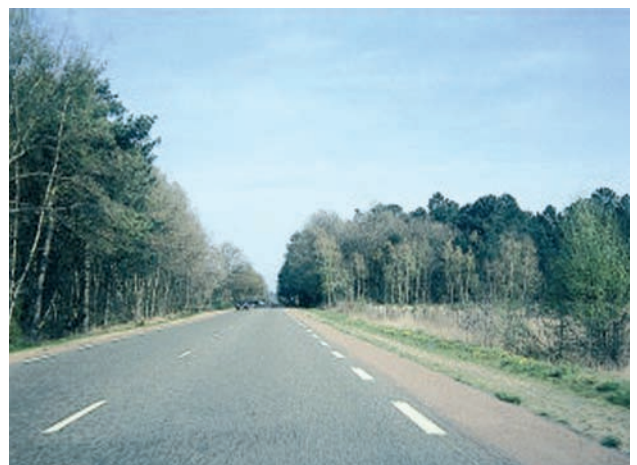
L'accotement avec un bon revêtement convient dans de nombreux cas.
