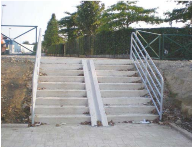
Goulotte au niveau d'une passerelle
