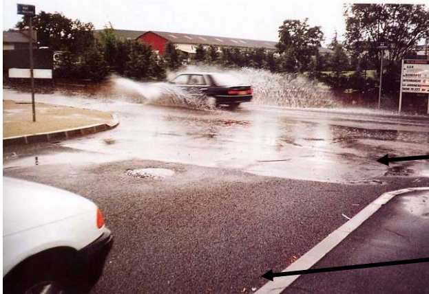
Chaussée à structure réservoir, Craponne (CERTU - 1994)
