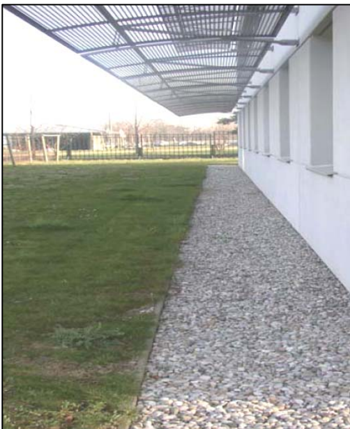
▶ Tranchées sous toit
