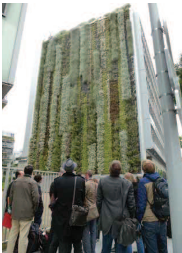
FIGURE 2: EXEMPLE DE MUR VÉGÉTALISÉ CANEVAFLOR (CAGES MÉTALLIQUES) QUARTIER SEGUIN RIVES À BOULOGNE-BILLANCOURT - © PLANTE & CITÉ
