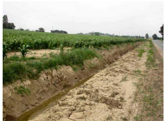
Fossé ayant été comblé par de la terre érodée après un orage en juin. Le tractopelle de la commune a dû intervenir pour sortir la terre.
