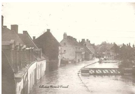
Crue du 01/11/1894 à St-Omer (Source : M. Bernard PONSEEL)
