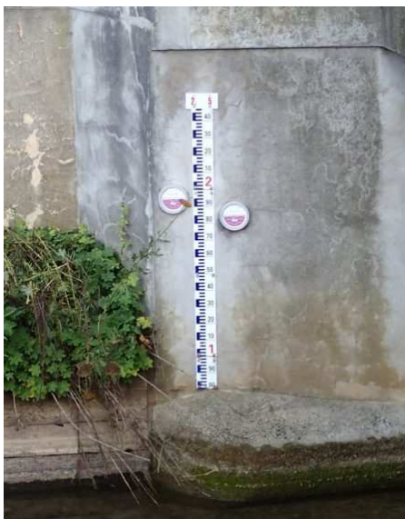
Repères de crues et échelle limnimétrique à Fauquembergues
