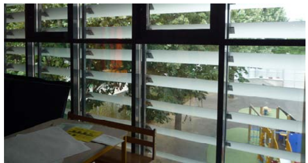
Photo : Pare-soleil dans l'école Lamoricière, école conforme au Plan Climat Energie de Paris, 12 ème arrondissement. © Marie Gantois/Mairie de Paris
