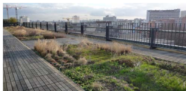
Photo : Toiture végétalisée expérimentale du 103 avenue de France, 13 ème arrondissement. © Marie Gantois/Mairie de Paris
