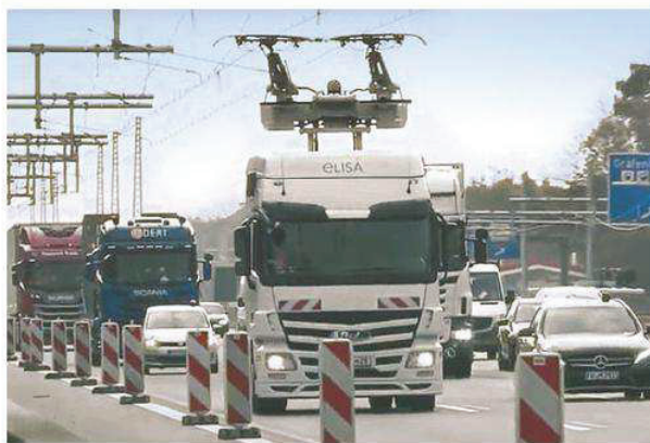
Sur la route fédérale A5 au niveau de Francfort (Allemagne), les camions hybrides se rechargent via le système de caténaires.
