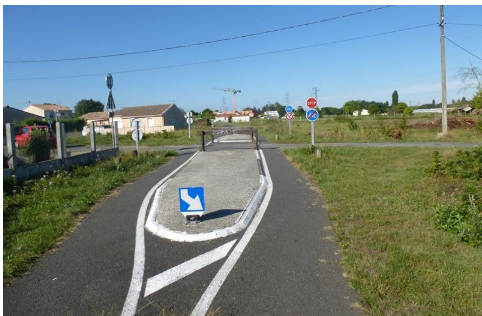
La construction d'îlot au droit de l'intersection aura le double effet d'alerter les usagers de la voie cyclable et d'augmenter la perception de l'intersection depuis la voie principale Source : Cerema
