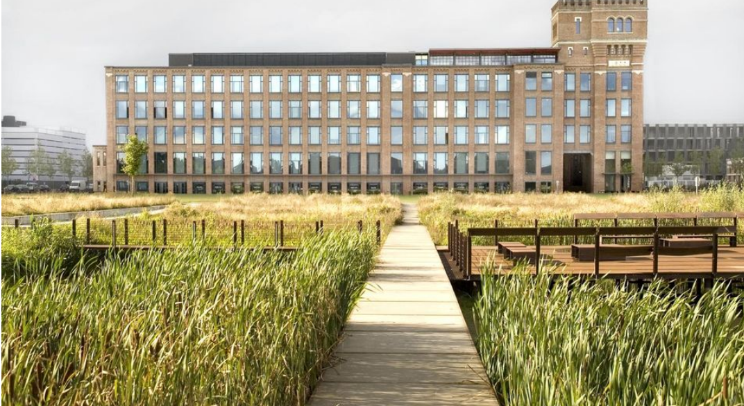
Ancienne usine Blan-Lafont reconvertie en pépinière d'entreprises. Lille, le 10 septembre 2013. christophe maout
