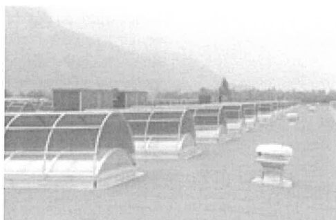
Photo 5.6. Exemple de protections solaires par l'extérieur sur lanterneaux en toiture, groupes de rafraîchissement d'air (caissons noirs au fond), extracteurs d'air (à droite).
