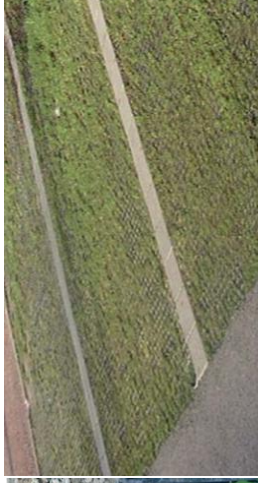
Exemple de places de parking enherbées non étanches (Source : Aménagement et eaux pluviales – Grand Lyon)
