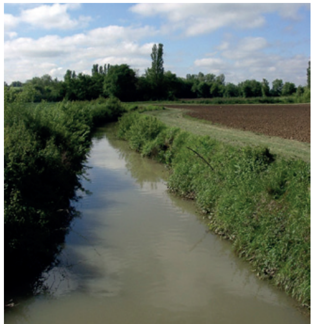
› Le Grand Auvignon : cours d'eau recalibré et rectifié, ripisylve absente.
