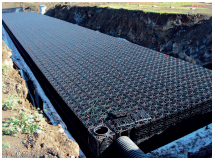
Chantier ACO Stormbrixx d'environ 450 m 3 réalisé à l'île de la Réunion dans la ville de St Leu, sous le parking du centre commercial Leclerc.
