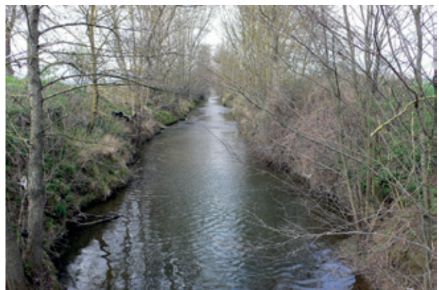
› Le Sor : cours d'eau recalibré et rectifié avec ripisylve homogène.
