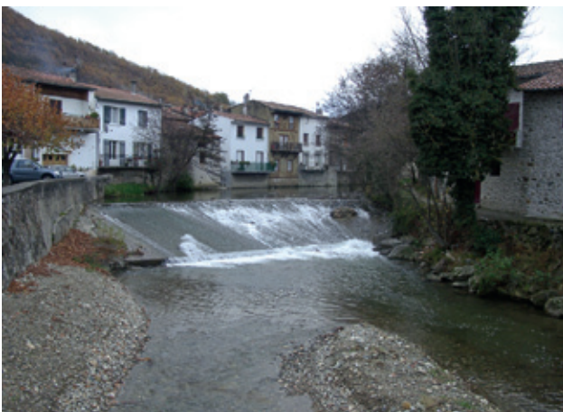
› L'Alsès : seuil transversal.
