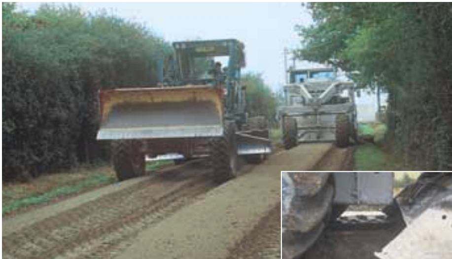
Passage du malaxeur et de la niveleuse après épandage de la chaux et du liant routier à base de ciment.
