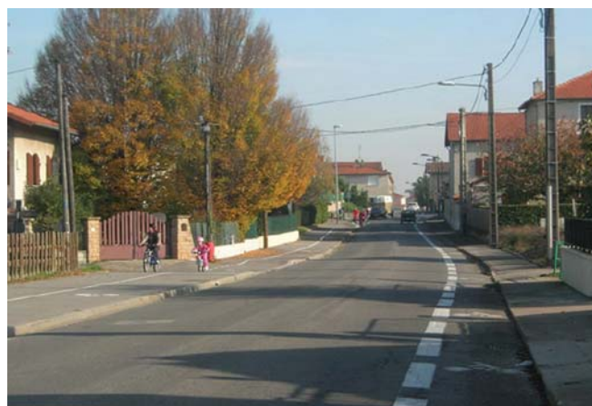
Ici amélioration de l'existant par suppression du marquage axial, création d'une bande cyclable sur la chaussée et d'une piste cyclable au niveau du trottoir en remplacement d'un ruban d'espace vert..
