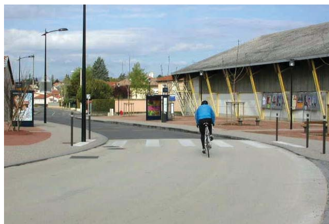
Sur la RD 150, forte restructuration du carrefour au droit de l'école des Brosses : surélévation de la chaussée, suppression des feux, rétablissement de la priorité à droite.
