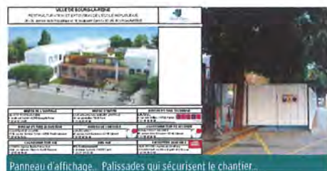
Panneau d'affichage... Palissades qui sécurisent le chantier...
