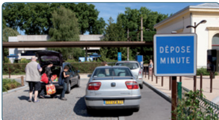
Aire de dépose-minute côté bâtiment voyageurs.
