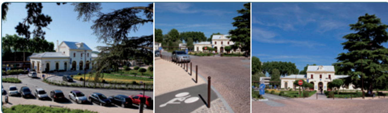
Accès apaisés côté bâtiment voyageurs.
