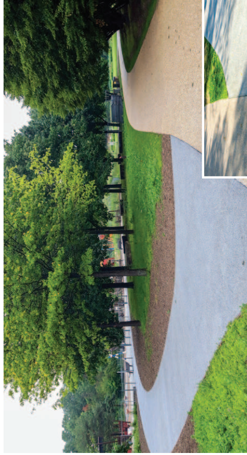
À gauche, allée en béton drainant ; à droite, allée en béton désactivé
