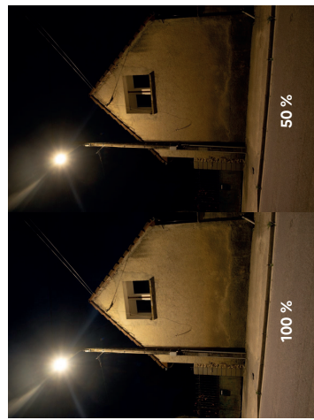
Illustration de gradation à 50 % du niveau lumineux en cœur de nuit, un des nombreux moyens de diminution de la consommation énergétique
