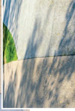
Jonction entre allée en béton désactivé (à gauche) et en béton drainant (à droite), les anciens pavés sont remplacés par des joints de calepinage
