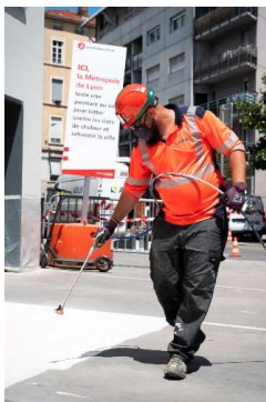
Lyon a expérimenté une peinture anti-chaleur. La température mesurée est passée de 47 à 37,9 °C.
