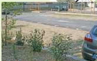
Places de stationnement perméables Source : Cerema
