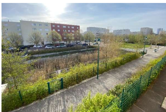
À Mantes-la-Jolie (Yvelines), ce bassin vert traite naturellement les eaux de pluie et rafraîchit son environnement proche.
