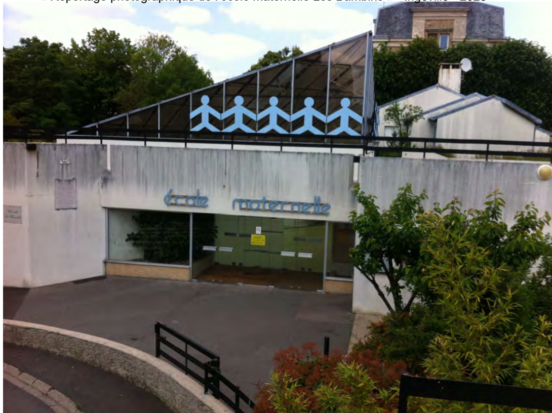
Photographie n°1 – Accès aux locaux de l'école et logement indépendant situé au-dessus de l'école visible à droite sur la photo
