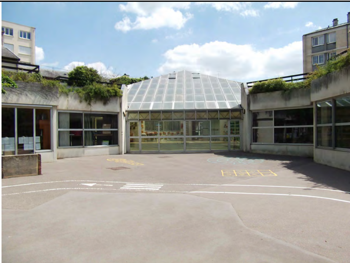
Photographie n°7 – Vue de la verrière depuis la cour de récréation
