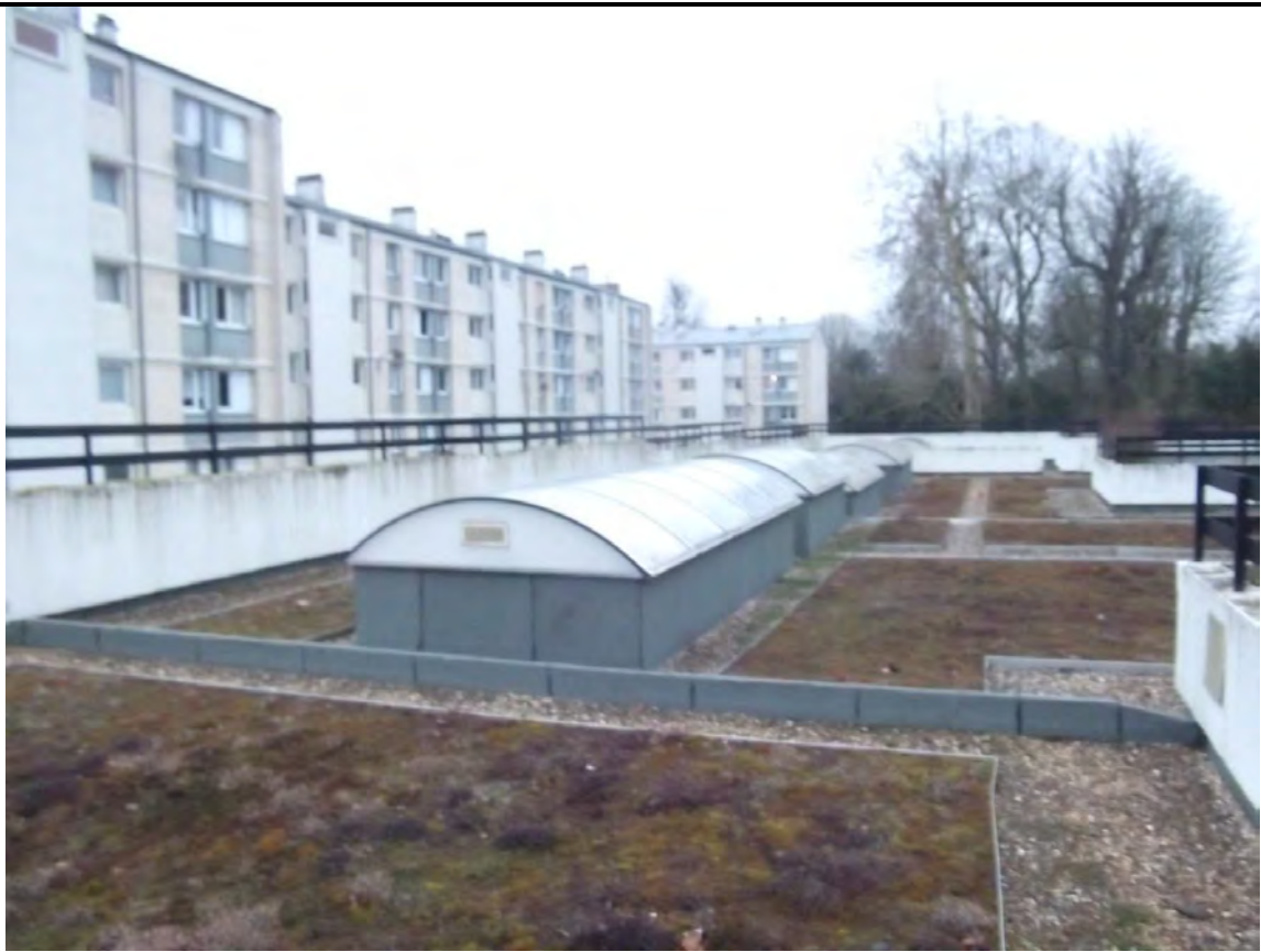
Photographie n°5 – Vue de la toiture végétalisée
