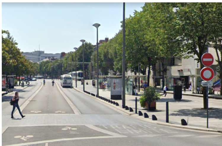
La zone à trafic limitée aménagée à Nantes, au niveau de l'arrêt Place du Cirque
