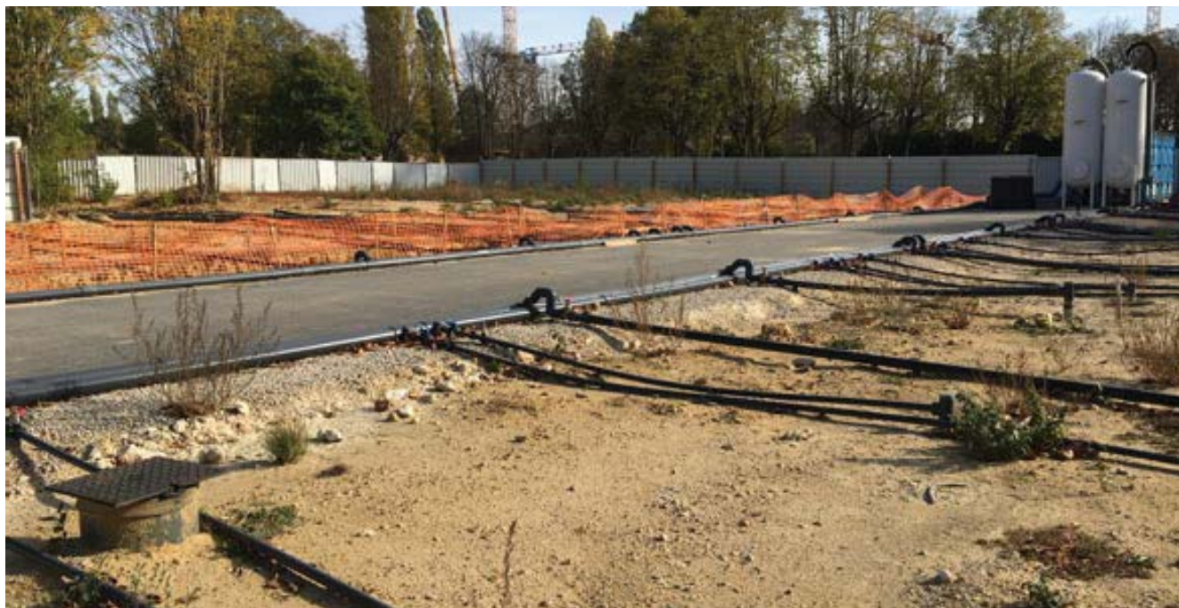
▲ Dépollution in situ par venting et sparging couplé à une oxydation chimique des polluants
