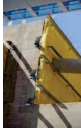
La pose d'isolant constitue l'un des bouquets de travaux utilisés dans la rénovation énergétique des bâtiments.
