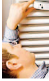
Ce répartiteur électronique permet l'estimation de la consommation de l'émetteur de chaleur.
