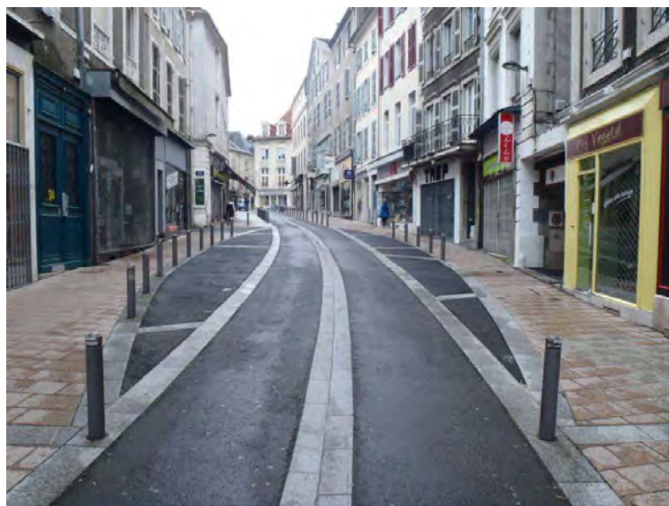
Matérialisation d'aires d'arrêt/croisement dans l'aire piétonne (Pau)
