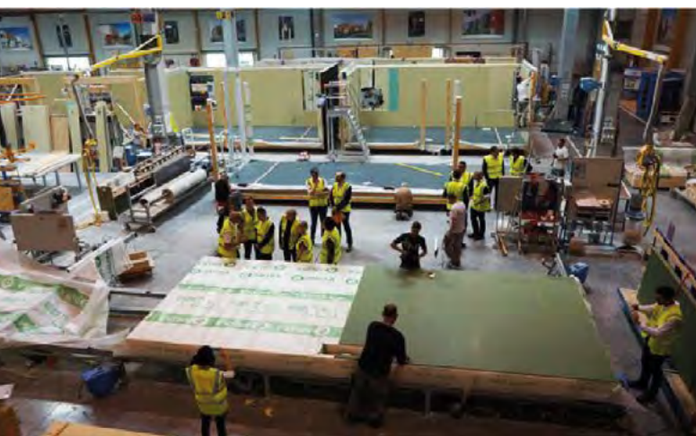
Montage du centre d'urgence, ©Aurore, 2016
