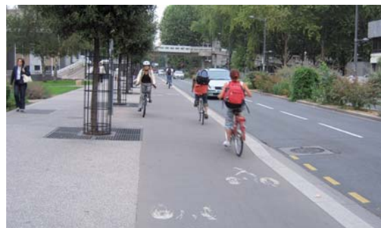
Piste contiguë à la chaussée
