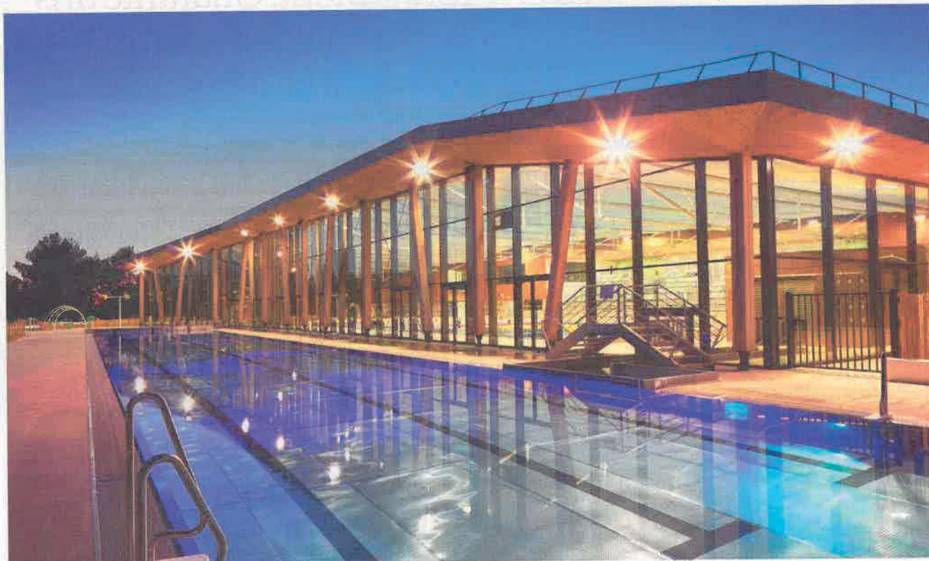
Inaugurée en 2016, la piscine Sainte-Victoire à Venelles (Bouches-du-Rhône) a fait l'objet d'un contrat réalisation, exploitation, maintenance. Outre trois bassins chauffés au bois, elle abrite une salle de musculation et une aire de jeu.
