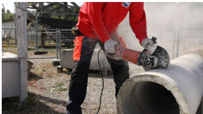
Utiliser un disque approprié à la découpe du béton et en bon état réduit la durée de la découpe et donc l'exposition au bruit.
