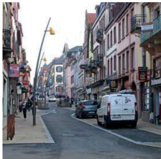
Dessin de la chaussée partagée sinueuse. Bordure très basse séparant l'espace de circulation mixte de l'espace dédié aux piétons. Des places de stationnement sont positionnées pour contribuer à l'effet de chicane par petits groupes (1 ou 2 places) ce qui permet de garder une perméabilité pour traverser.
