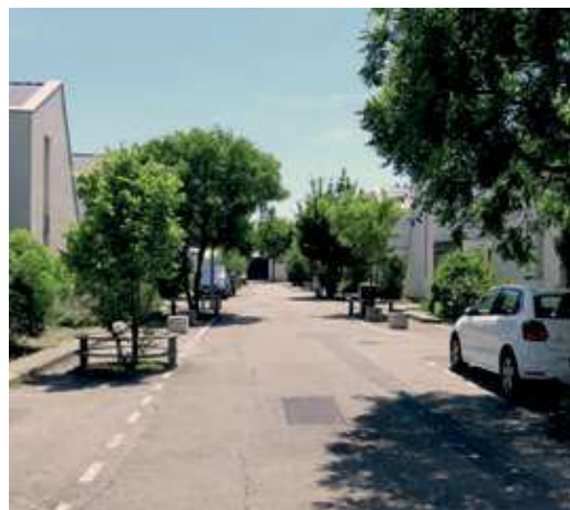
Dans ce stationnement organisé en « bordure de façade » (ci-dessus), les espaces latéraux de la chaussée sont utilisés pour de la végétation avec arceaux permettant l'assise. Des bacs de poubelles ont été installés pour organiser des places de stationnement, matérialisées par un marquage réglementaire. Dans ce quartier résidentiel, les piétons utilisent le centre de la chaussée pour se déplacer.
