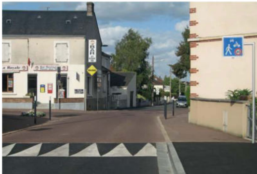
L'entrée de la zone de rencontre est matérialisée par une différence de matériaux et de couleur, avec un plateau surélevé.
