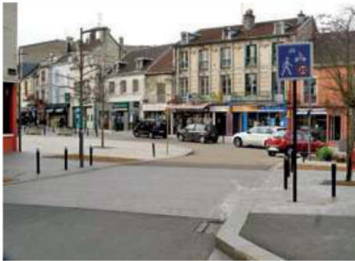
Ici, le changement de revêtement attire l'attention. Il est bien contrasté, adapté aux malvoyants. Le passage de matériau de type enrobé noir à un revêtement clair à l'entrée de la zone est propice à alerter l'automobiliste sur le changement de statut de la voirie.
