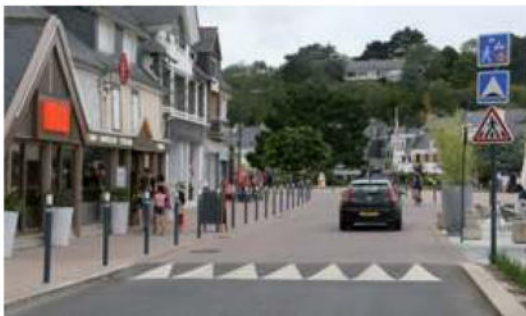
Ici, c'est la présence du plateau et le changement de matériaux de la chaussée qui marquent le changement de zone. La différence de traitement doit être évidente (source : F. Tortel).
