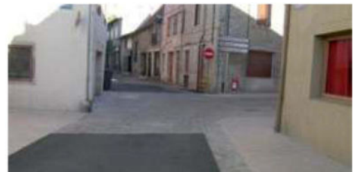
Carrefour d'une zone de rencontre où aucun axe n'est prioritaire. Il est marqué par un changement de matériau des chaussées.
