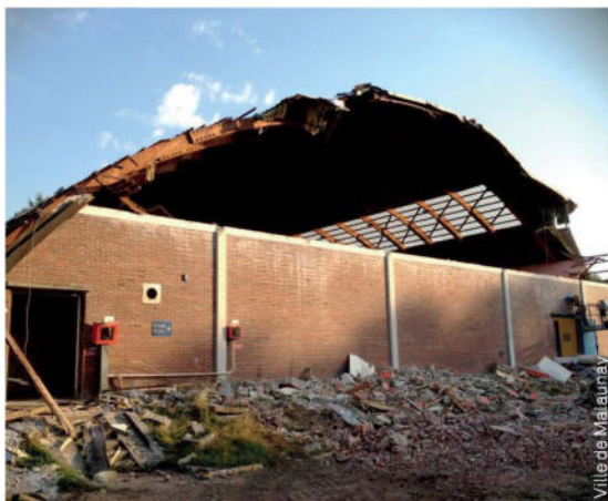
Gymnase avant travaux
