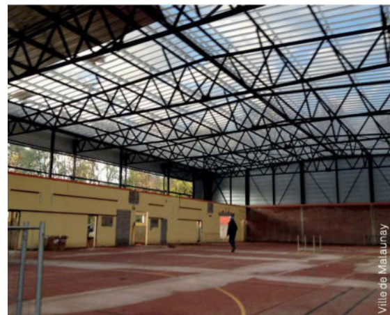
Gymnase après travaux
