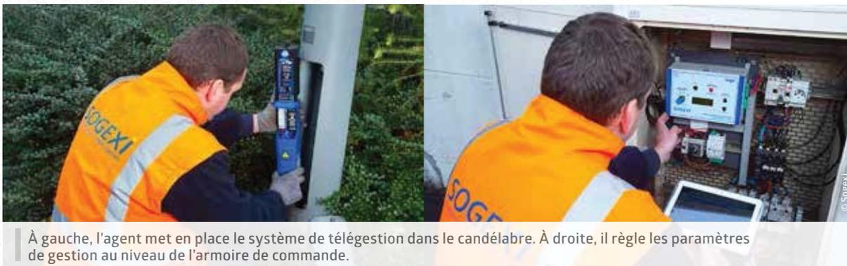
À gauche, l'agent met en place le système de télégestion dans le candélabre. À droite, il règle les paramètres de gestion au niveau de l'armoire de commande.
