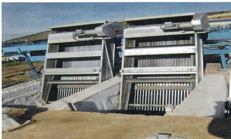
**Figure III.4:** Photo de la grille mécanisée (2 unités)
