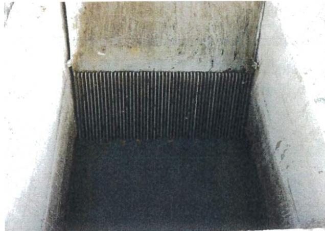
**Figure III.5:** Photo de la grille manuelle de by-pass
