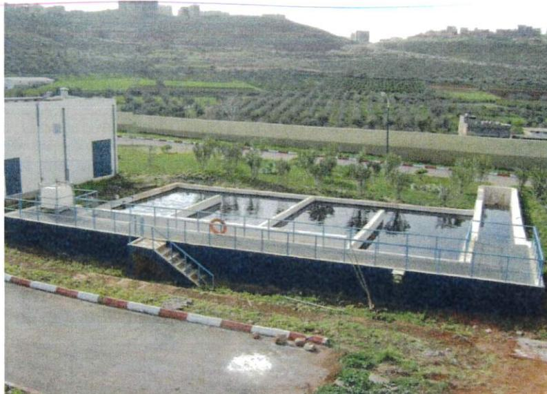
**Figure III.11:** Photo du bassin de chloration
