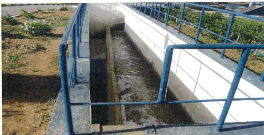
Figure III.2: Photo du déversoir d'orage.
