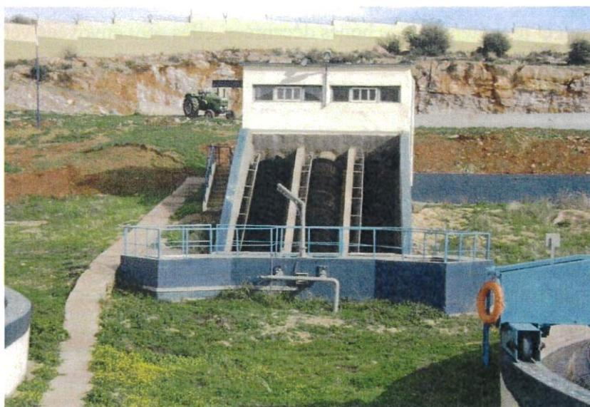
**Figure III.12 :** Photo des vis de recirculation des boues
