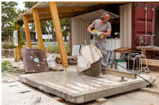
*Après collecte, sciage de lamelles et de murs aux dimensions souhaitées pour un réemploi. A la Fabrique du Clos, à Stains. BELLASTOCK – ALEXIS LECLERCQ*
