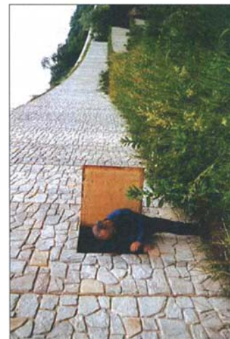
FIGURE 13 - Exemple de trappe de visite.
