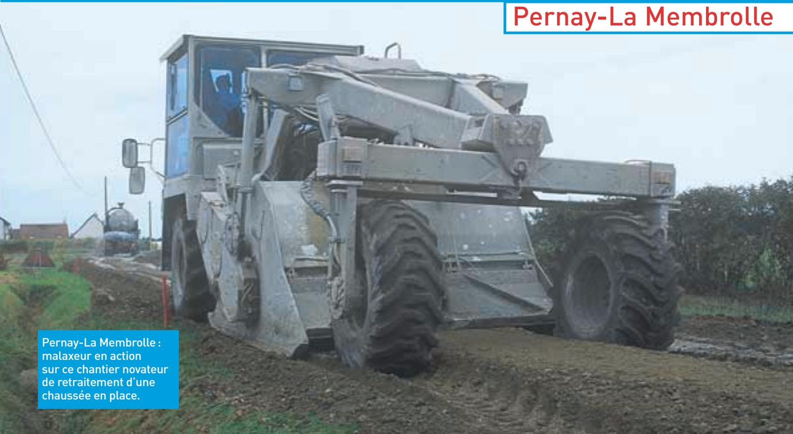
Pernay-La Membrolle : malaxeur en action sur ce chantier novateur de retraitement d'une chaussée en place.
