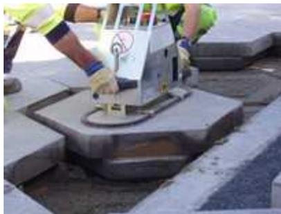
Ces dalles amovibles permettent un accès rapide aux réseaux, améliorent la durabilité des propriétés de surface des chaussées et peuvent être recyclées. Leur préfabrication devrait permettre de proposer d'autres fonctions intégrées (textures variées, surfaces poreuses, silencieuses ou dépolluantes, insertion de capteurs, etc.).
