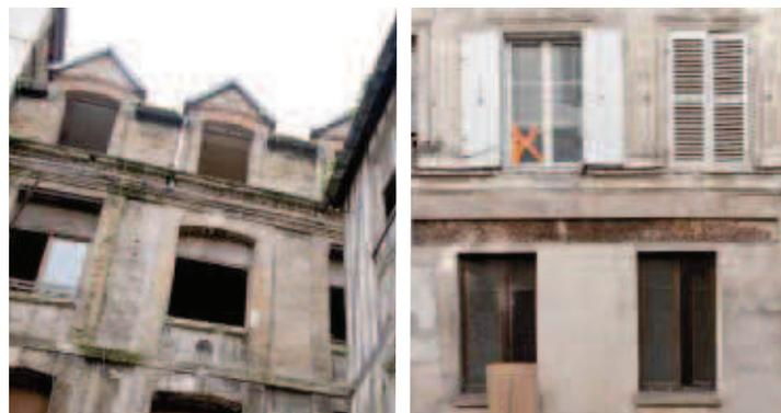
Le diagnostic de ces éléments doit porter sur la sécurité (bonne fixation ou ancrage des composants pour éviter toute chute sur la voie publique) et sur le niveau de dégradation empêchant leur fonctionnement ou provoquant des dégradations sur le bâti : état et qualité des protections des bandeaux ou corniches pour assurer l'évacuation de l'eau, état des canalisations pour éviter les infiltrations dans les murs et les logements, état des menuiseries en terme d'étanchéité à l'air et à l'eau...
