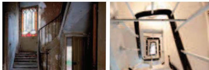
Pour assurer la sécurité des personnes, les espaces de circulation doivent présenter un sol régulier (risque dû aux tomettes décollées, à la déformation du plancher, à un sol glissant...) et un bon éclairage. Les ascenseurs et les équipements pour la sécurité incendie doivent faire l'objet d'un diagnostic particulier.
