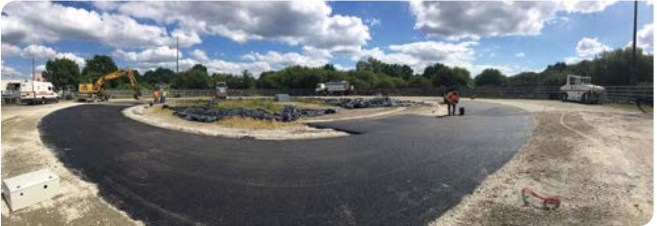
Illustration 1 - Chantier du démonstrateur de chaussée entièrement recyclée à l'aide de liants bio-sourcés (projet Européen BIOREPAVATION) © IFSTTAR
